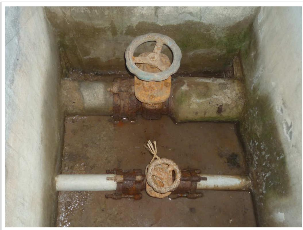
*Ft. 2: Tubo superior desagüe de vaciado balsa, tubo inferior canalización a sustituir*
