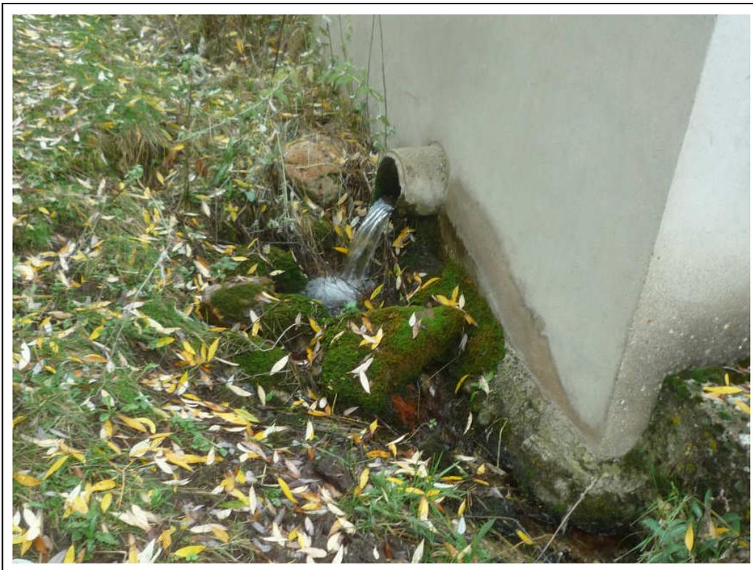
*Fotografía 4: Tubo aliviadero de balsa, de 20cm. de diámetro interior*
